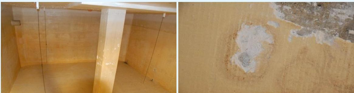
**Abb. 5:** Fallbeispiel: Innenbeschichtung im Reservoir der oberen Druckzone.
