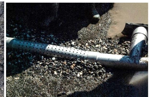
Abbildung 6: Sickerrohre DN 150
