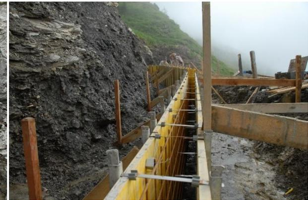
Abbildung 4: Schalungsarbeiten
