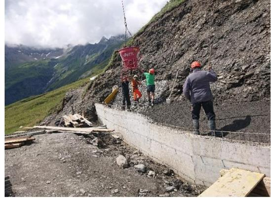
Abbildung 8: Magerbeton fliegen
