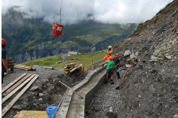
Abbildung 7: Einbringung Geröll mittels Helikopter
